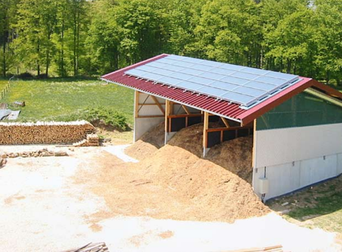
Die neue Hackschnitzeltrocknungshalle mit drei Silofeldern fasst 1.000 Schüttraummeter Hackschnitzel.
