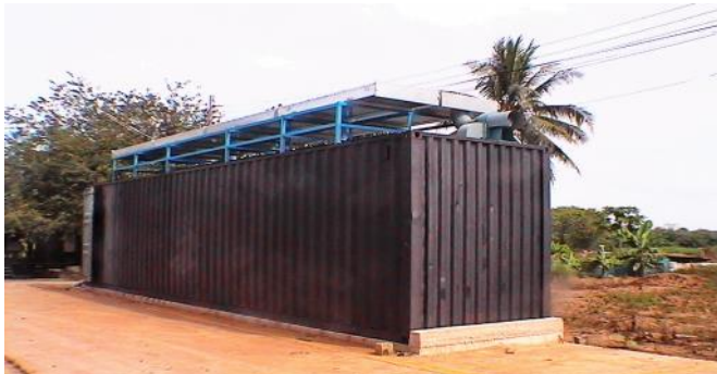
Cámara de secado solar de caucho, Tailandia
