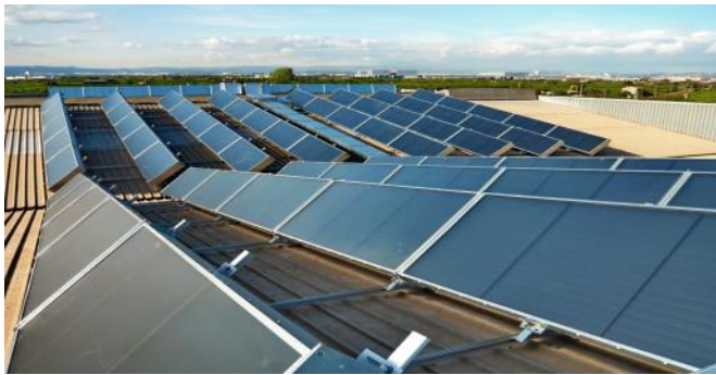
160 m 2 JUMBOSOLAR para secado industrial de naranjas, España
