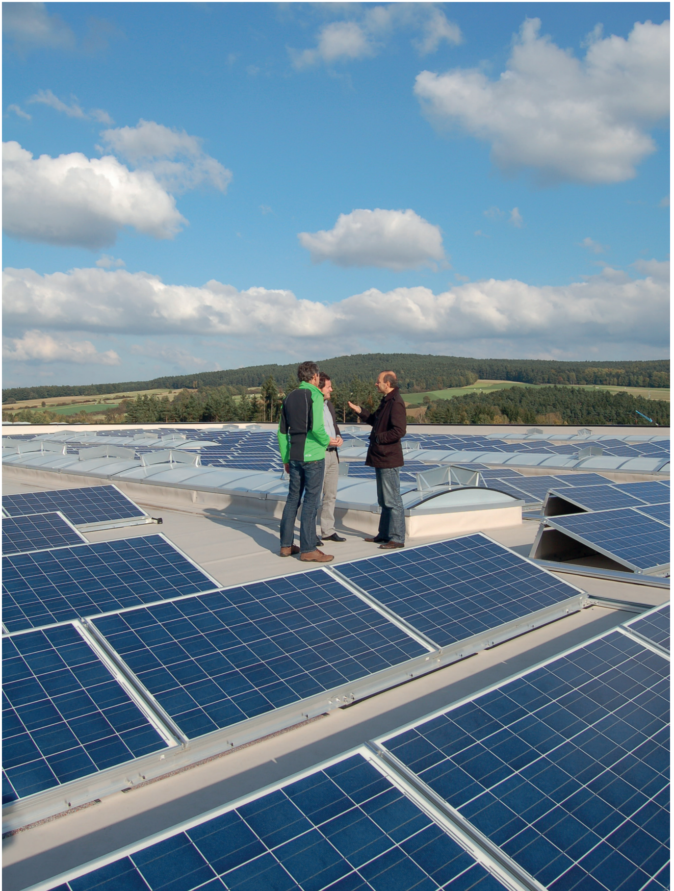
PV-Anlage baumann automation Amberg
